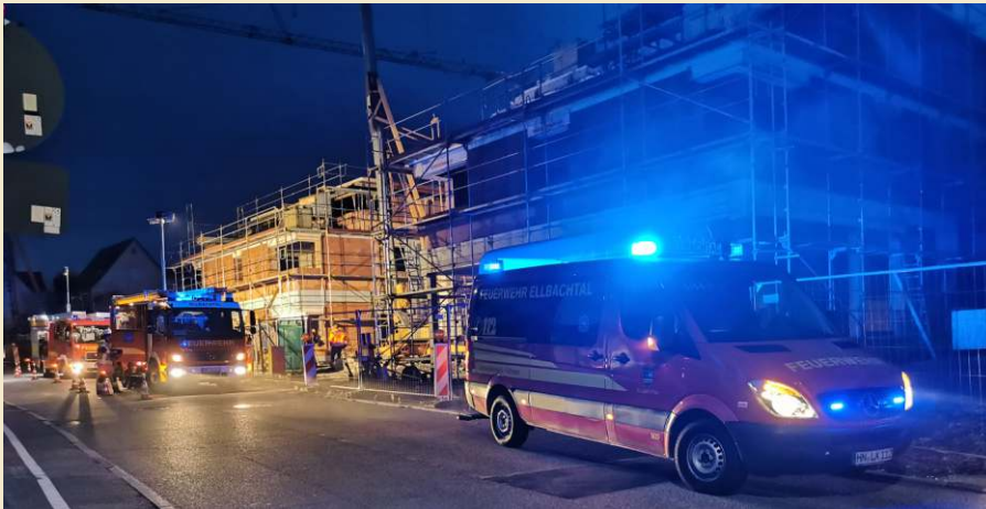
September 2022 Feuerwehrrübung der freiwilligen Feuerwehr Ellbachtal auf der E1 Baustelle
